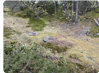
Utvendig påkobling vann
