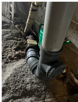
Stakeluke, soil skjøtet inn på pvc rør
