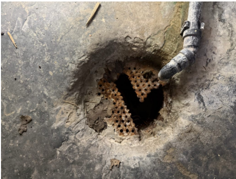
Eldre støpejernsluk i gulv.
