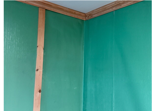
Tapetsert/gjenkledd pipe på kjøkken.
