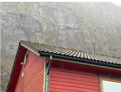
Taktekking sett fra bakkenivå. Taktekking er mosegrodd flere steder. Mose bør fjernes.
