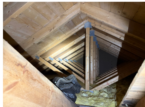
Takkonstruksjon over tilbygd del.
