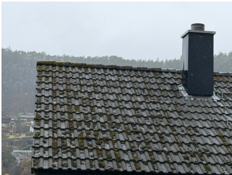
Taktekking sett fra bakkenivå.
