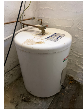
Varmtvannstank i vaskekjeller.
