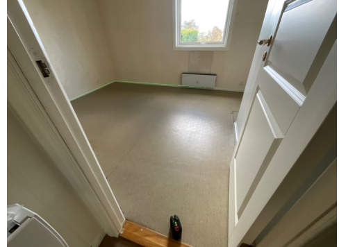
15 mm høydeforskjell gjennom soverom.
