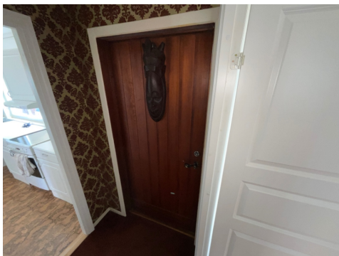
Ytterdør i trevirke.
