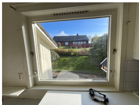
Kjøkkenvindu med lufting.
