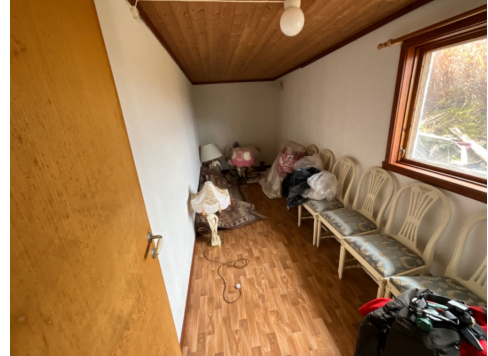
Det ble fuktmålt i påforingsvegg helt til høyre, i bakkant på bildet
