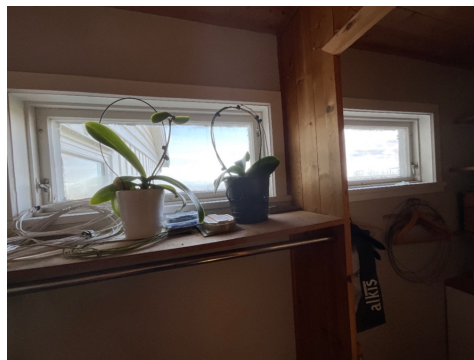
Vinduer med koblede glass.
