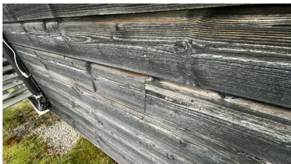
Noe småsprekker/slitasje for kledning. Vurderes som naturlig patina.
