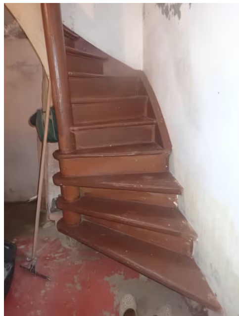
Trapp mellom første etasje og underetasje.
