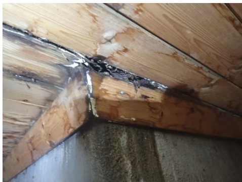
Lekkasje ved pipe på kaldtloft.
