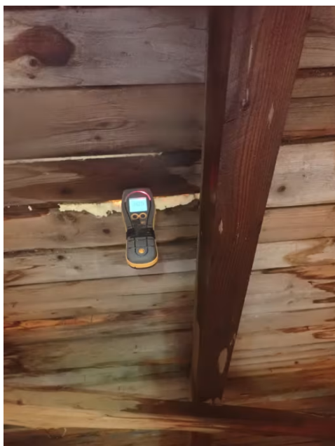
Lekkasje ved pipe på kaldtloft.
