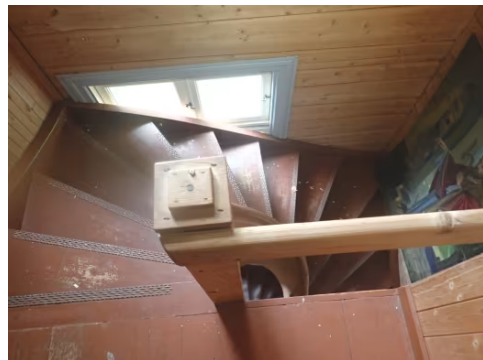
Trapp mellom første etasje og loft.
