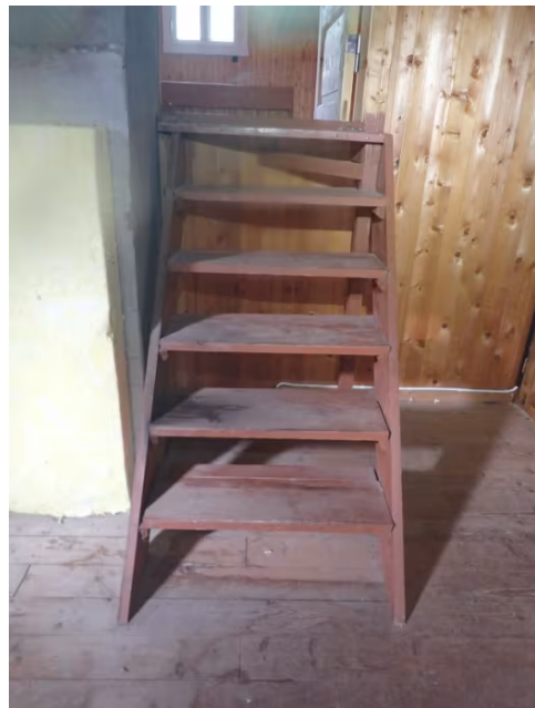
Trapp til kaldtloft.
